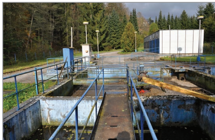
Zastávka druhá - čistírna odpadních vod
